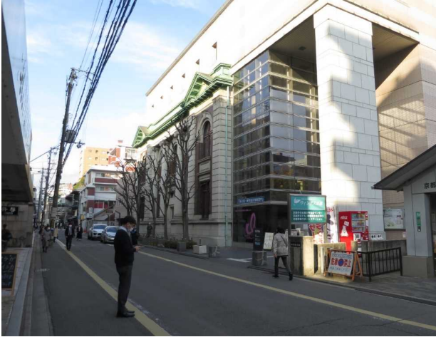
①配電線 (会場入口付近)
