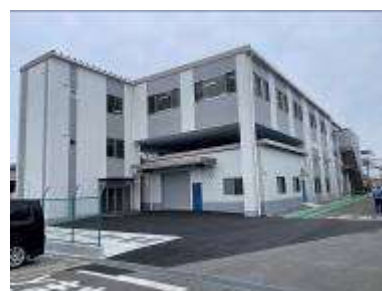
増築した水素分野の研究施設
