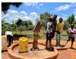
▲ Hand pump-equipped borehole
