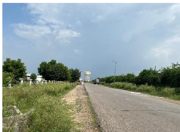
団地内の施設(舗装道路、高架水槽)
