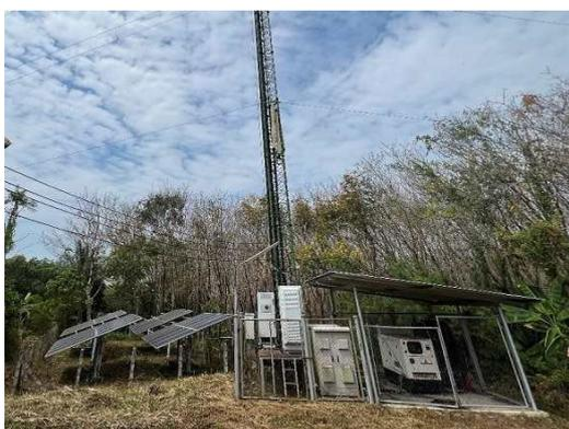
図 4-20 携帯電話基地局用電源設備
