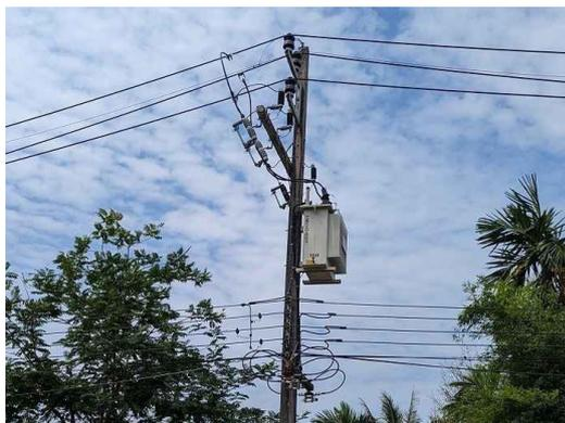
図 4-7 柱上変圧器(100kVA)
