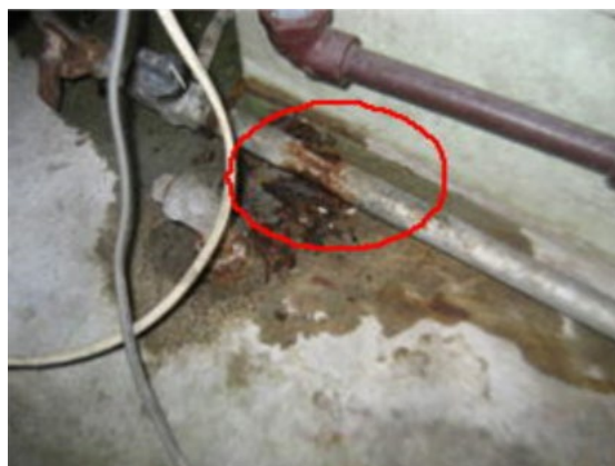
図 2.2.2.1 配管の腐食
