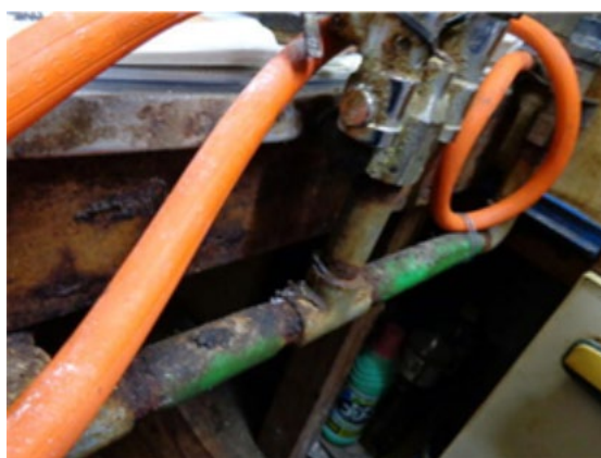
図 2.2.2.2 配管の腐食
