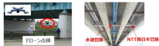
ドローン飛行により撮影した画像にて共同点検を実施
