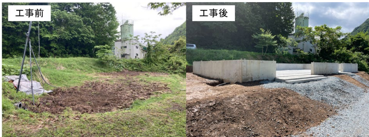
図 2.8-4 土間基礎工事前後の現地状況
