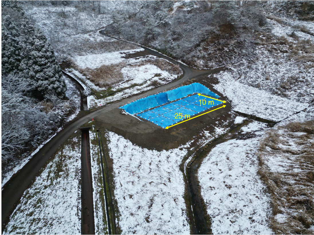
図 4-2 モデル鉱山における PT 実導入試験設備の工事の様子
