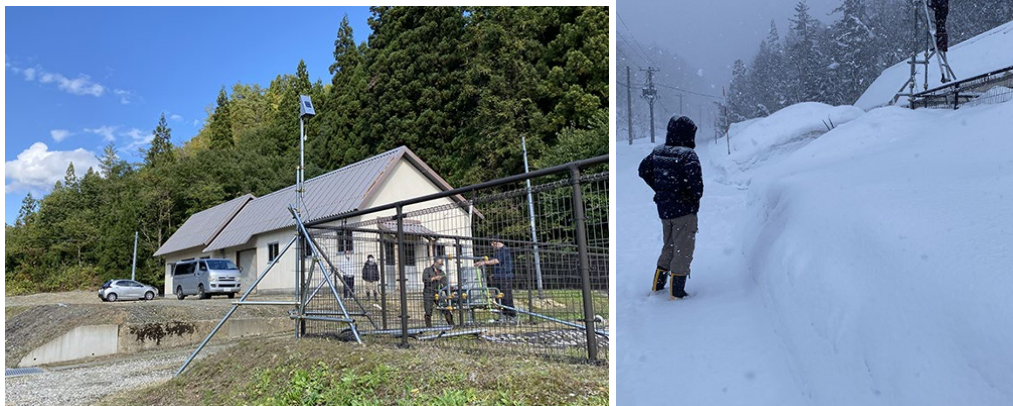
図 3-12 鉱山 B における水質モニタリングと送信機設置の様子、左：外観、右：冬季に中継機を設置したときの様子
