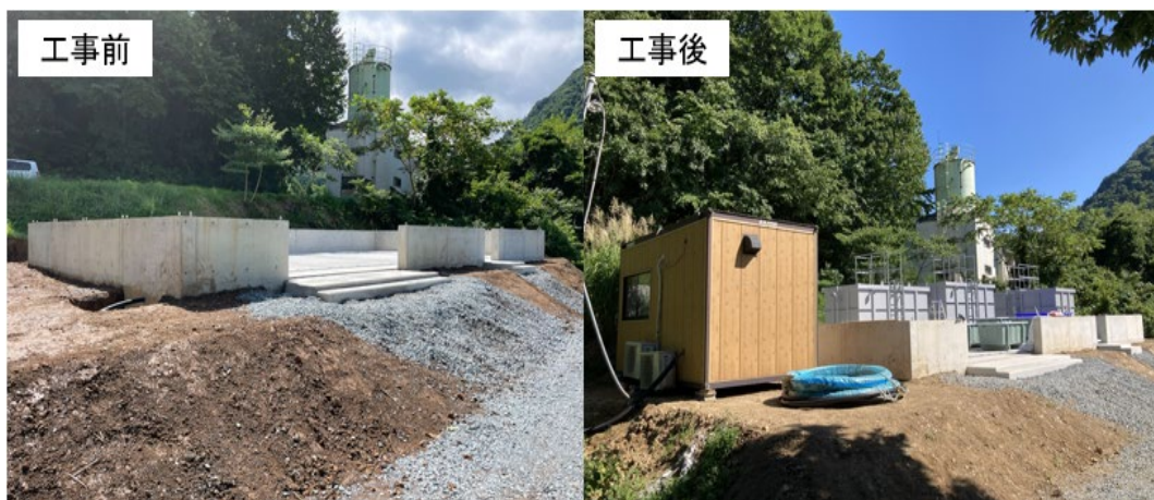
図 2.8-9 PT 実証試験設備製作設置工事前後の現地状況
