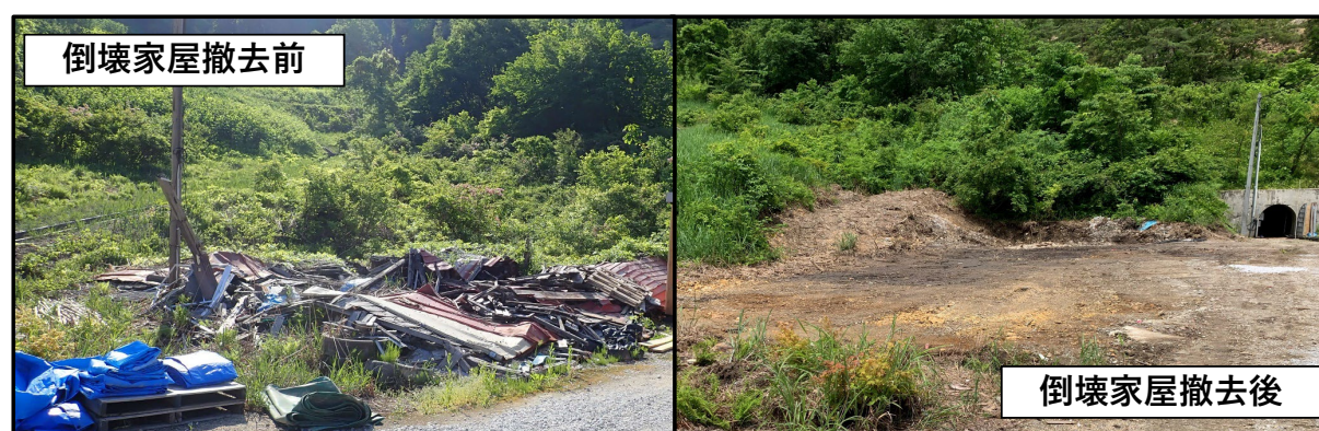
図 2.5-23 倒壊家屋撤去状況
