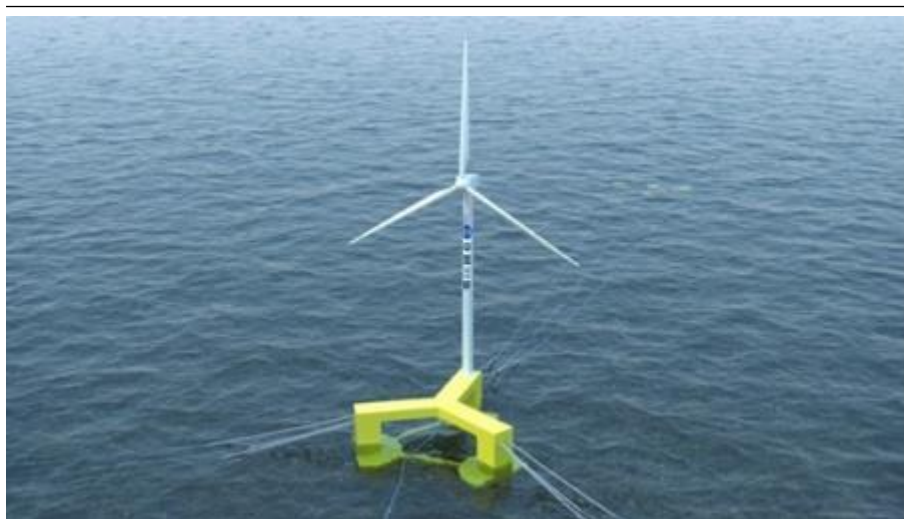
中国三峡集団5.5MW浮体式洋上風力基礎 2
