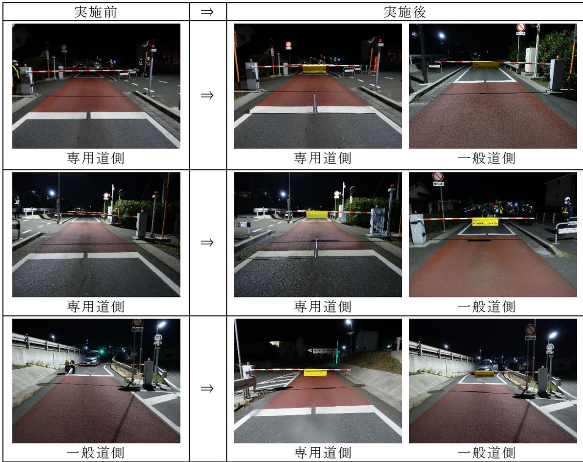
図 7-23 垂れ幕の取付前及び取付後の状況 (①河原子)
