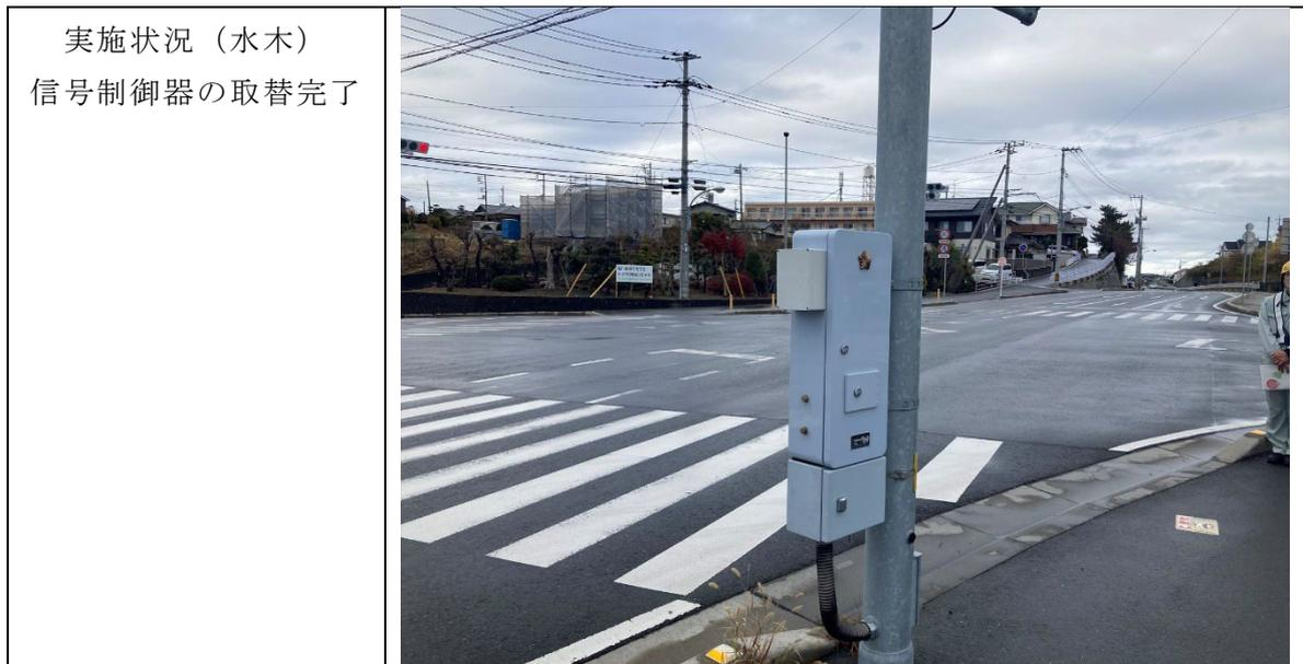
図 7-49 信号制御器取替工事作業状況
