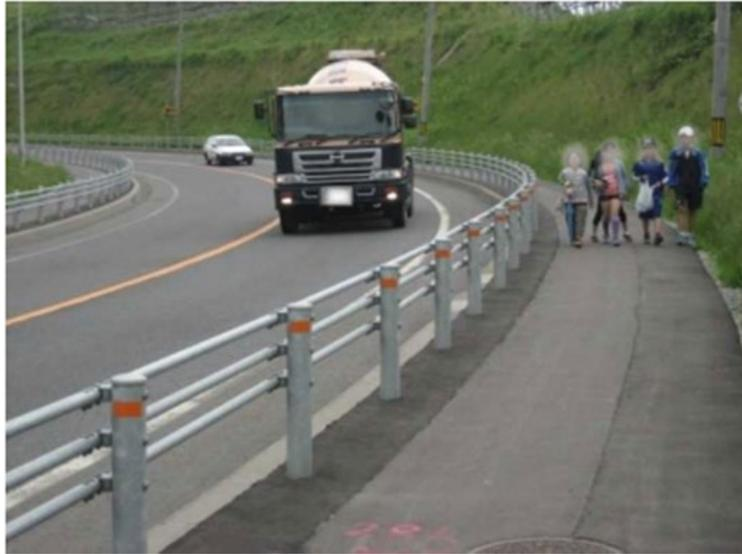
図 6.2-20 ガードレール設置の事例
