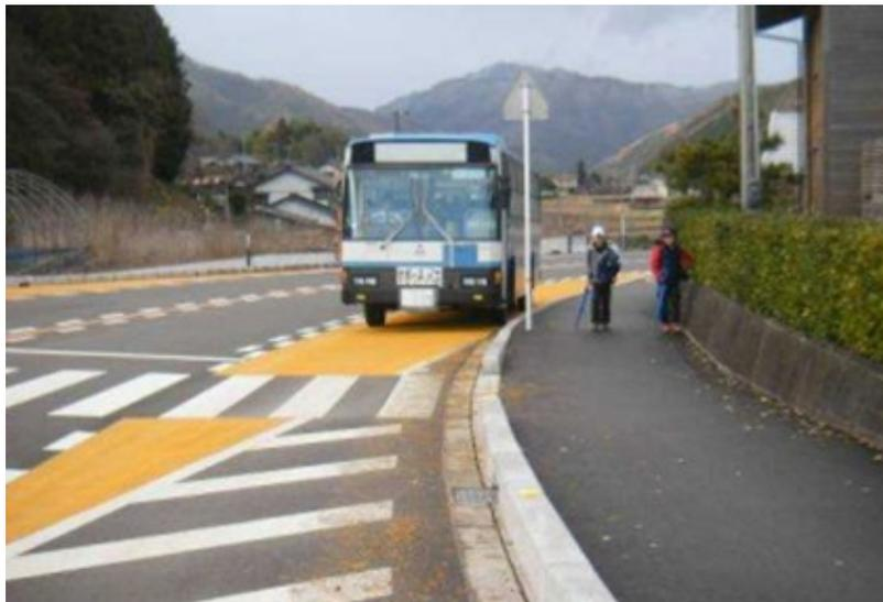
図 6.2-1 勾配部、曲線部のバス停の整備例
