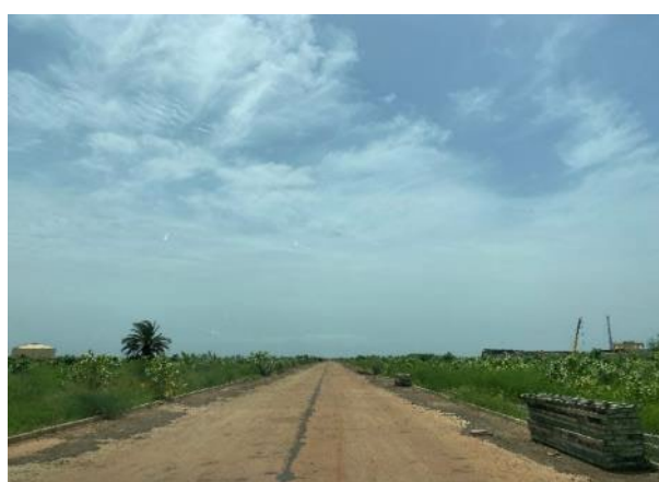
⑤ 工業団地内道路
