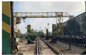
ウンゲニ台車交換施設
