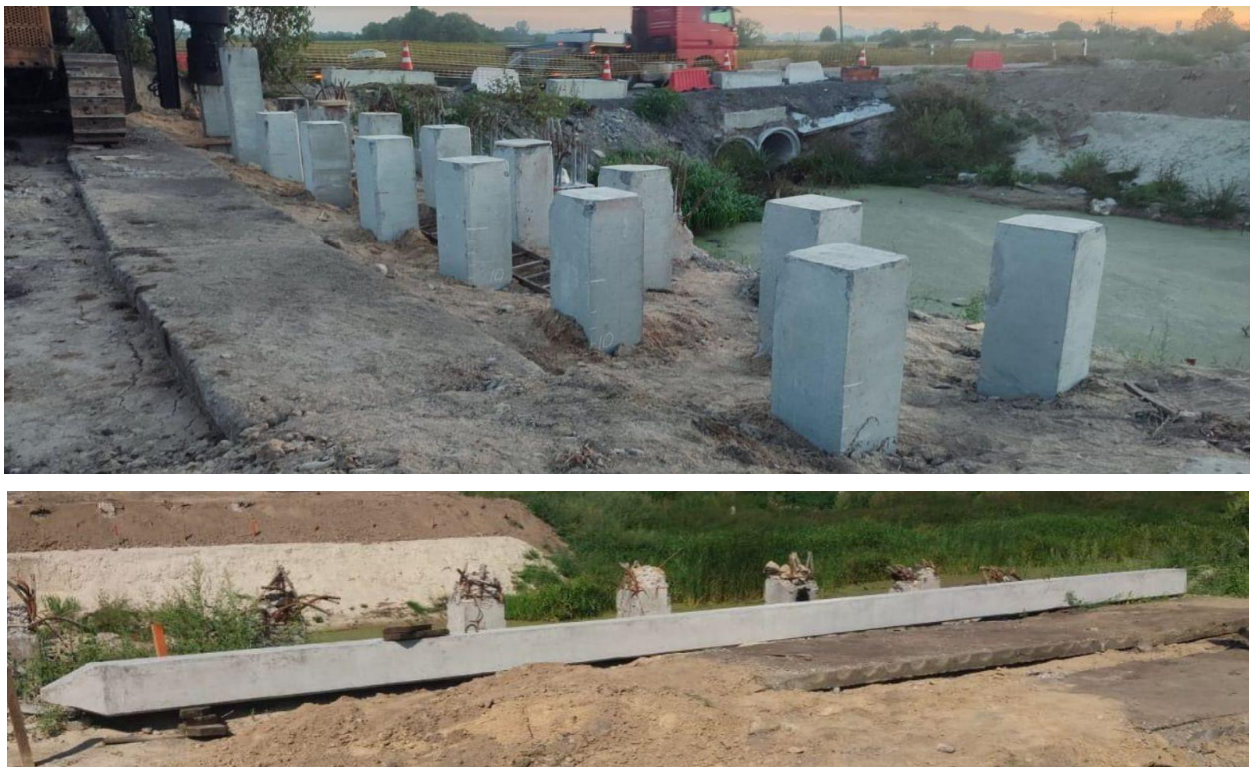
図 4.6.2 コンクリート既製杭
