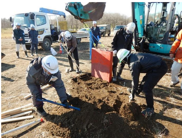
図 4.1.2.2-9 実験場における L 型擁壁設置状況
