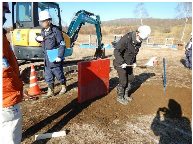
図 4.1.2.2-9 実験場における L 型擁壁設置状況
