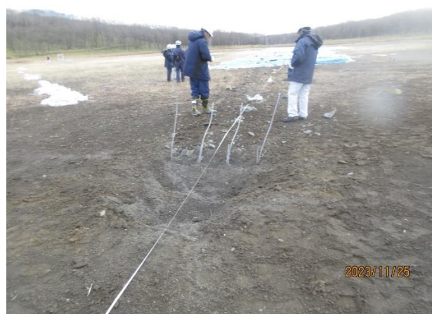
図 4.1.3.2-4 実験後の試験体の状況
