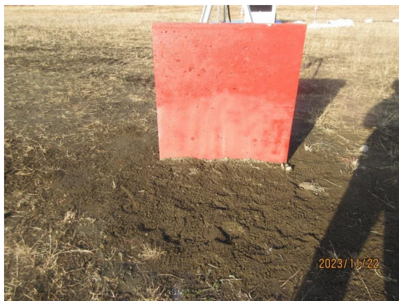
図 4.1.3.2-2 設置された実験前の試験体 ( 実験 No.1-3 擁壁)
