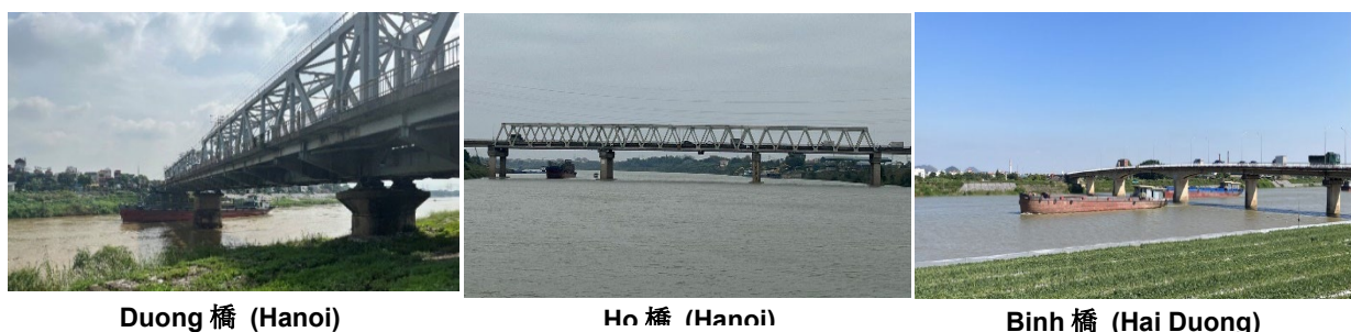
図 3.3-5 クリアランスが低い既存の橋梁 3 カ所
