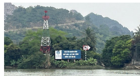
航路標識設置例
