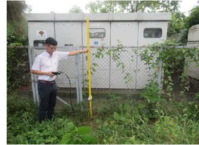
③受電設備 (大磯町役場周辺)
