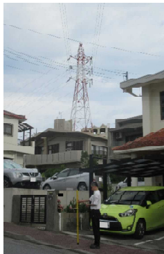
①送電線 (奥武山公園駅周辺)
