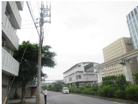
②配電線・ケーブル立上り (旭橋駅周辺)
