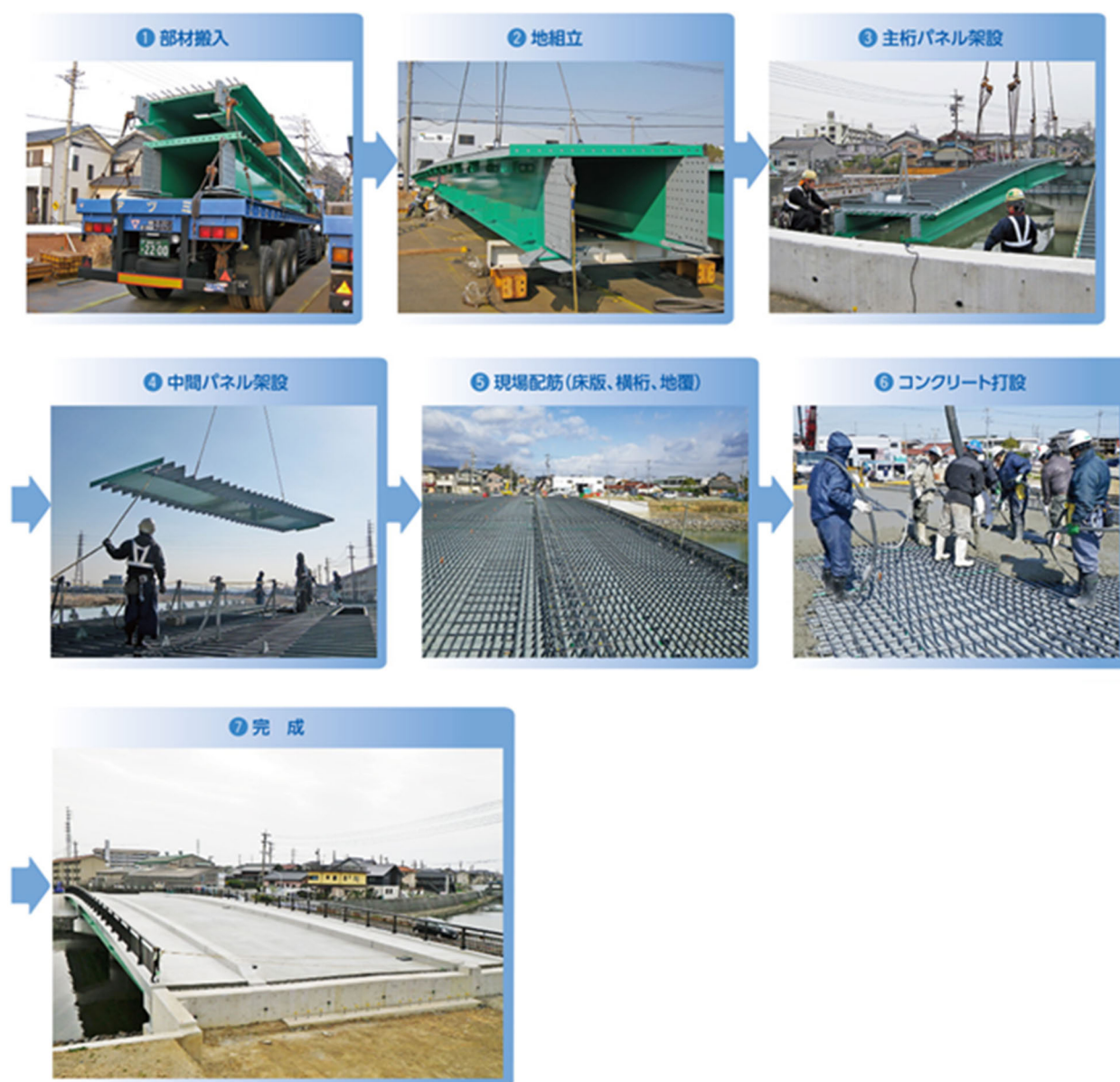
図 5.4.2 鋼鈑桁橋（合成床版）【パネルブリッジ】の施工手順
