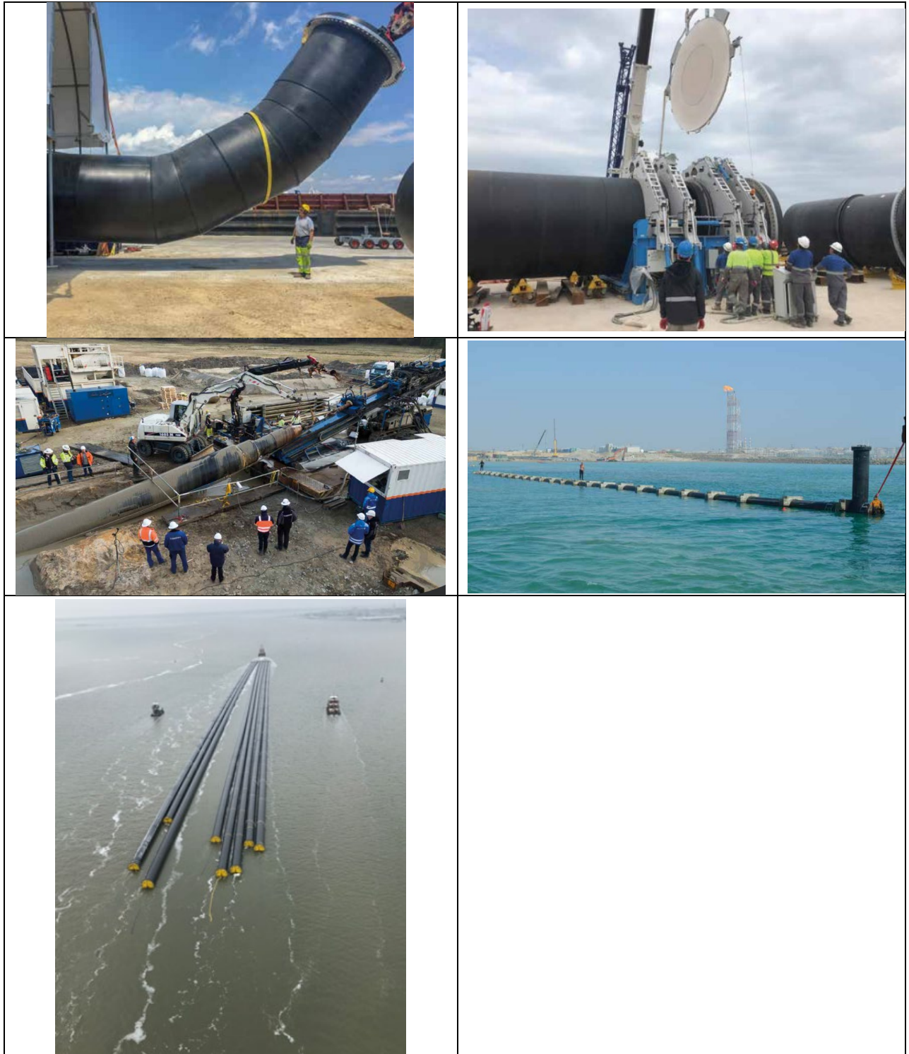
図 80 AGRU 社 HDPE 管 施工写真
