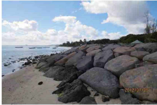
図 50 Pte. aux Sables の巨石護岸
