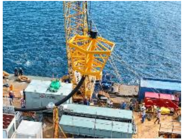
図 69 取水口の事例-2（富山県入善深層水：管径 250mm）
