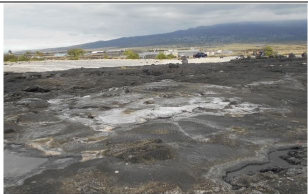
55"中間ピットをコンクリートで埋め戻した様子
