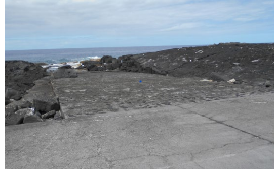
40"トレンチ掘削後のコンクリート埋め戻し箇所
