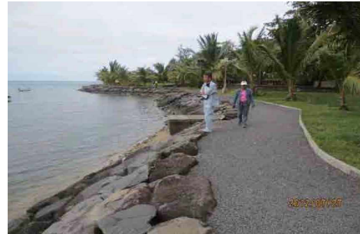
図 50 Pte. aux Sables の巨石護岸
