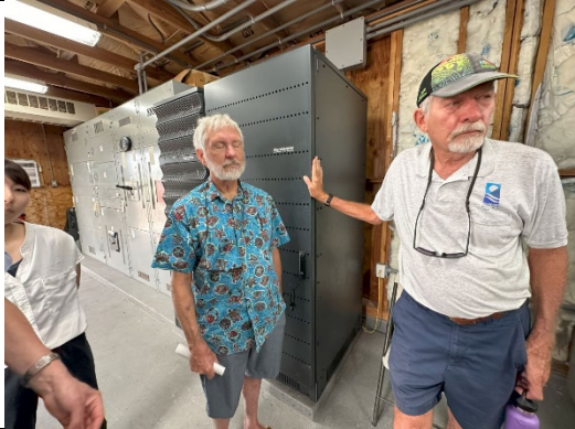
真空ポンプ用 UPS
