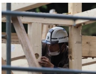
施工現場の職人
