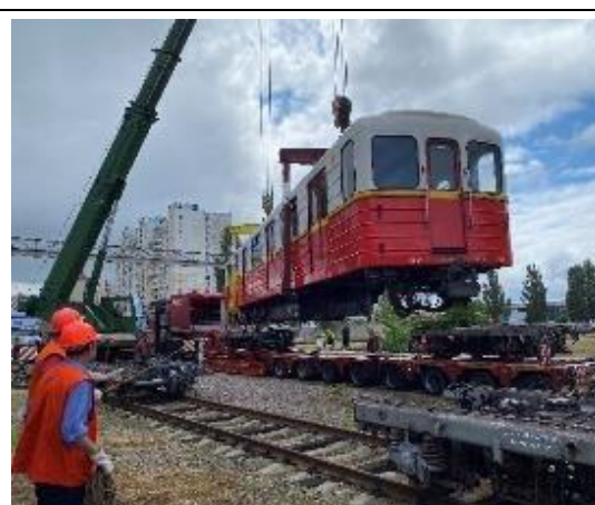
荷下ろしの様子
