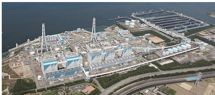
図 5 JERA 碧南火力発電所
