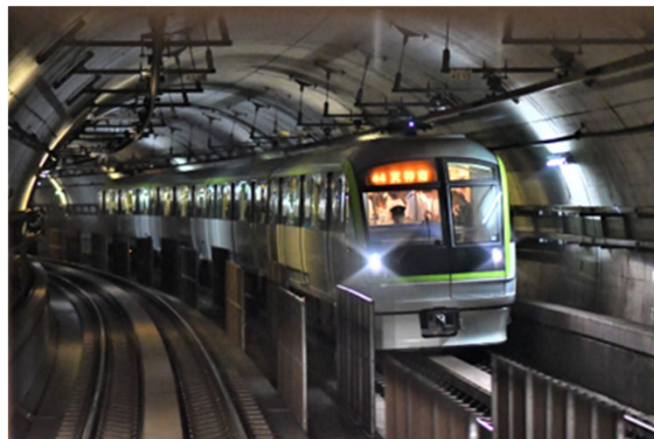
地下区間（七隈線、福岡市）
