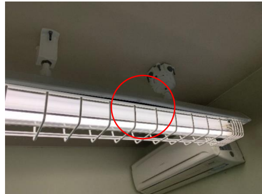
写真 19 蛍光灯の変形箇所 (丸印) (調査時)
