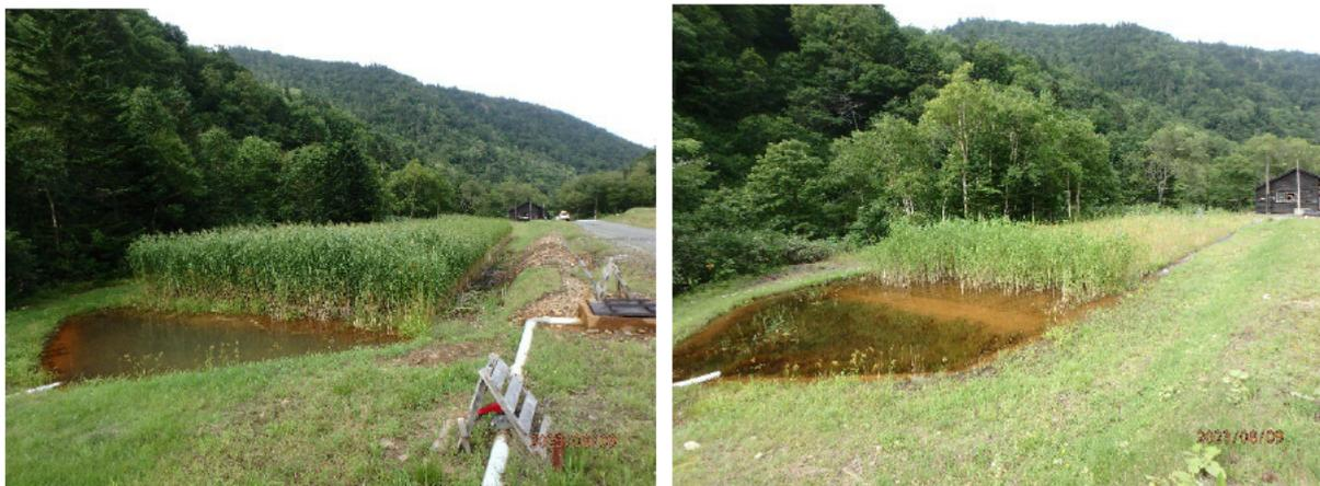
図 2.8-4 小規模人工湿地の運用状況（左：表面流型、右：浸透流型）
