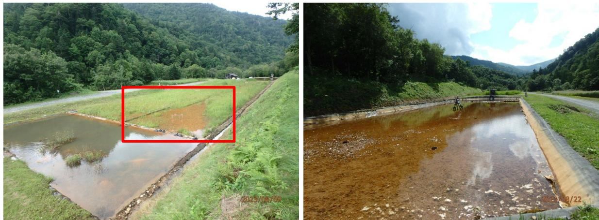
図 2.8-3 実規模人工湿地の運用状況（左：表面流型、右：浸透流型）
