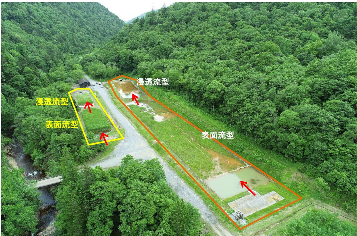
図 2.8-2 人工湿地の様子（赤枠：実規模、黄枠：小規模）
