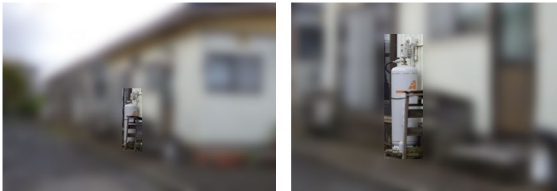
図 6-5 被害箇所の建物（左）と LP ガス設置状況の例（右）
