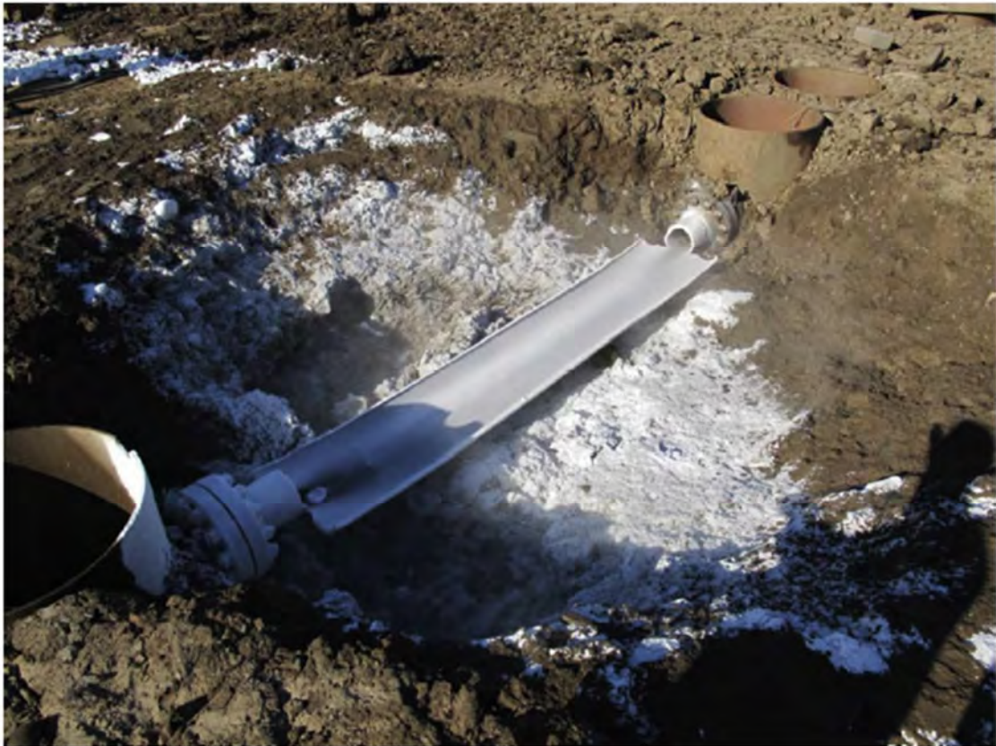
図 3.3-8 破裂後のパイプとクレーター
