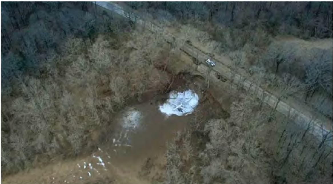
図 3.2-8 パイプライン破断箇所（白い箇所）と周囲の地滑り部 7
