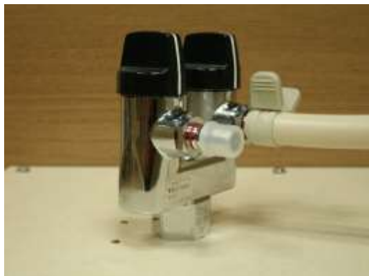
保護キャップを装着したガス栓
