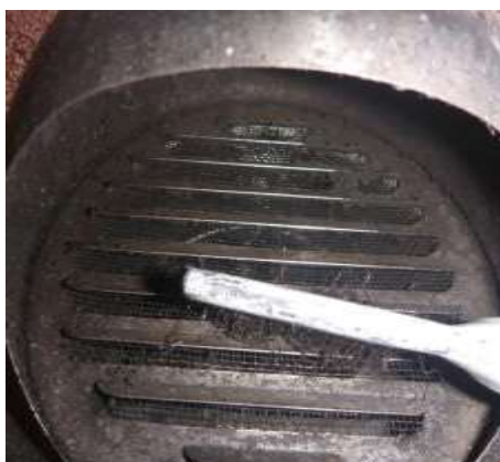
給気口の清掃の様子
