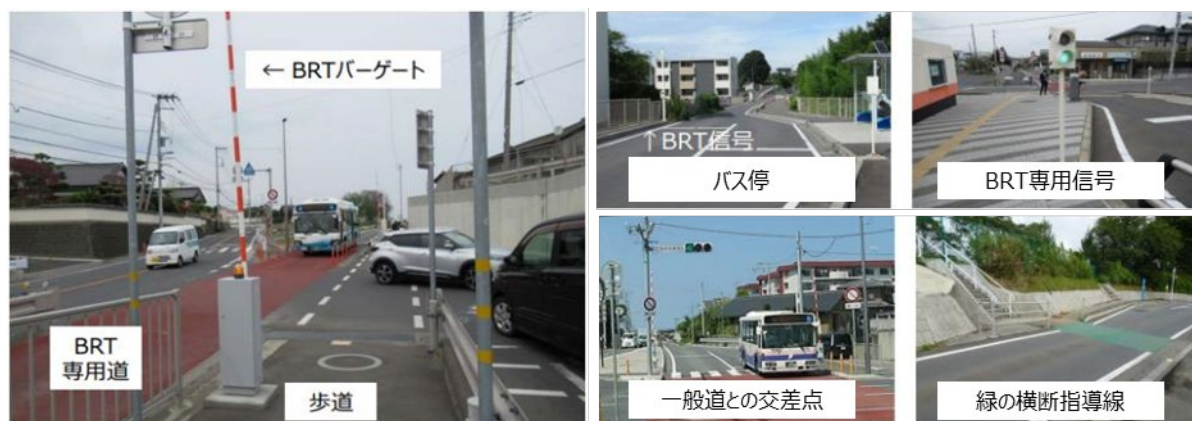
図 1.1.1-2 BRT 専用道区間の走行環境
