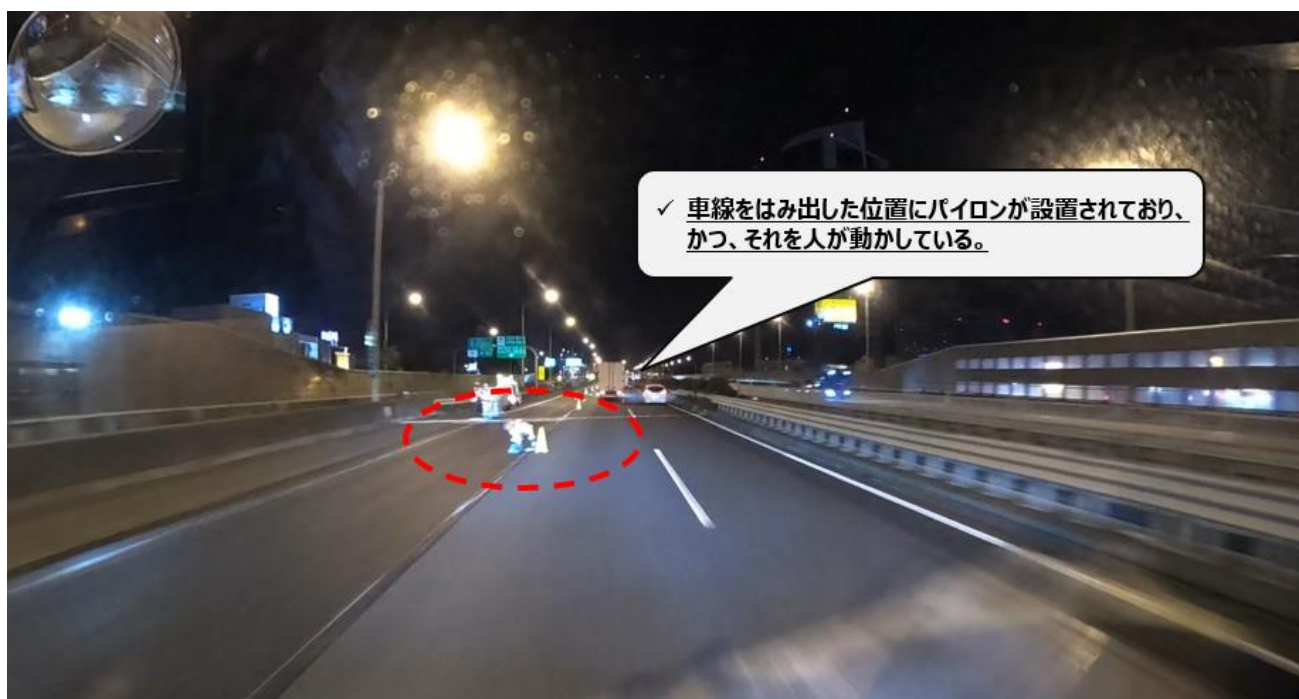
図 2.9 車線内に設置されたパイロンを動かす作業員
