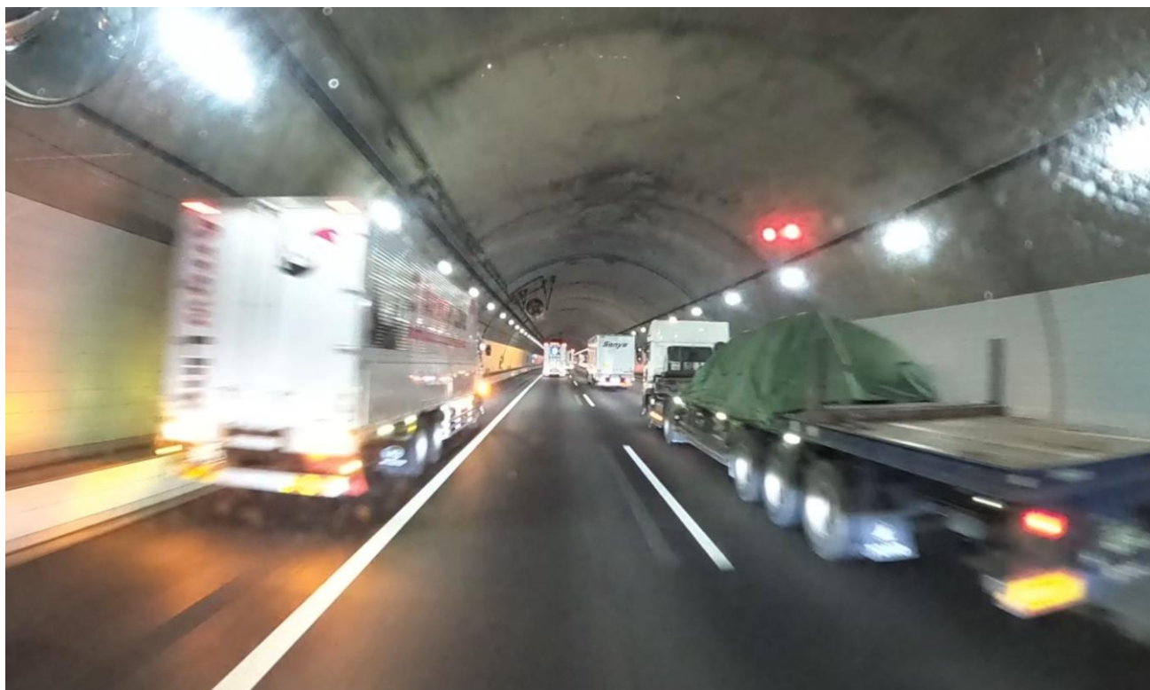
図 2.7 トンネル内の路肩に故障車が停車
