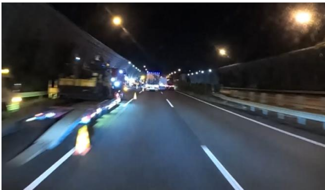
図 2.8 車線内に設置されたパイロン
