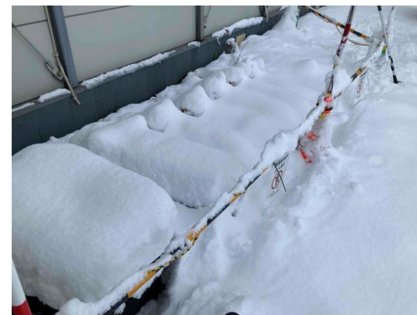
防護物設置状況(積雪後)
