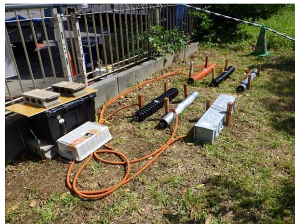
管路等の設置状況
