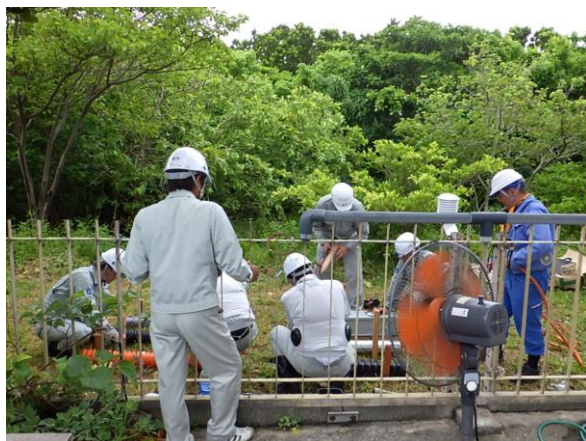
暴露試験設備構築状況
