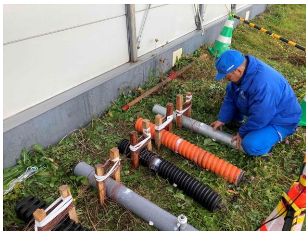
暴露試験構築状況
