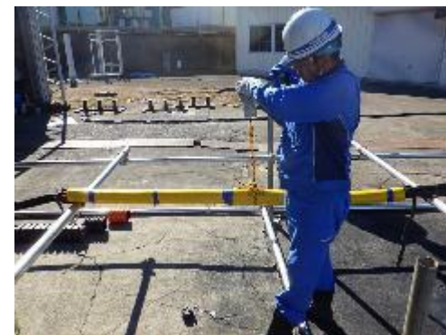
ケーブル重量確認
