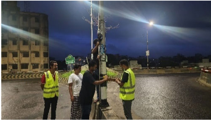
観測地点におけるカメラ設置の様子
