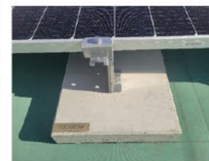
横浜市立元街小学校に導入した太陽光発電設備とCO 2 -SUICOM
