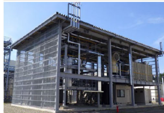
INPEX長岡鉱場に作られた8Nm 3 /h級のメタネーション試験装置
