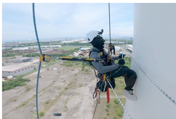
保守点検作業 [写真出所] 株式会社北拓 HP
