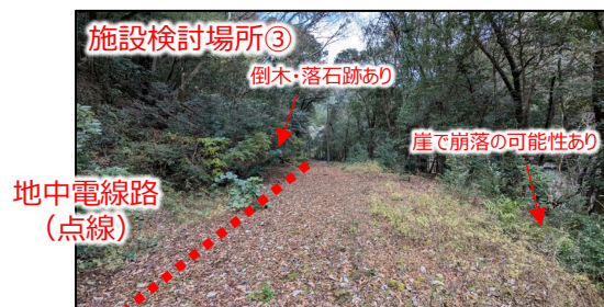
現地写真および施設イメージ図（赤線部）
