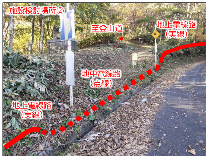
現地写真および施設イメージ図（赤線部）
