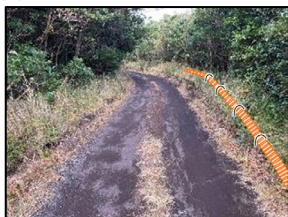
①管路を地面に沿って平行に施設
