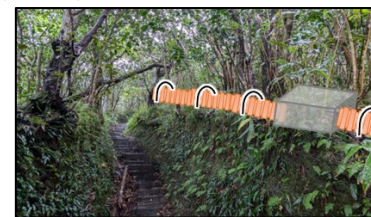
③接続箱を地面に沿って平行に施設
