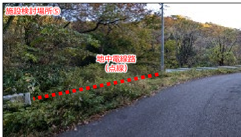
現地写真および施設イメージ図（赤線部）
