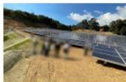
▲改善した事業計画による再施工中の様子
