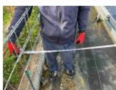
▲柵・標識の設置
