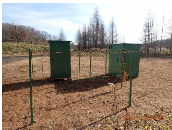
図 4.0-6 火薬類取扱所（左）と火工所（右）
