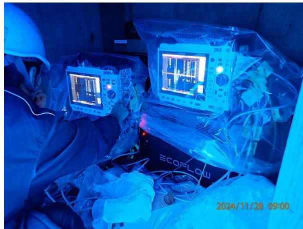
計測ボックス内の地盤振動計測機器
