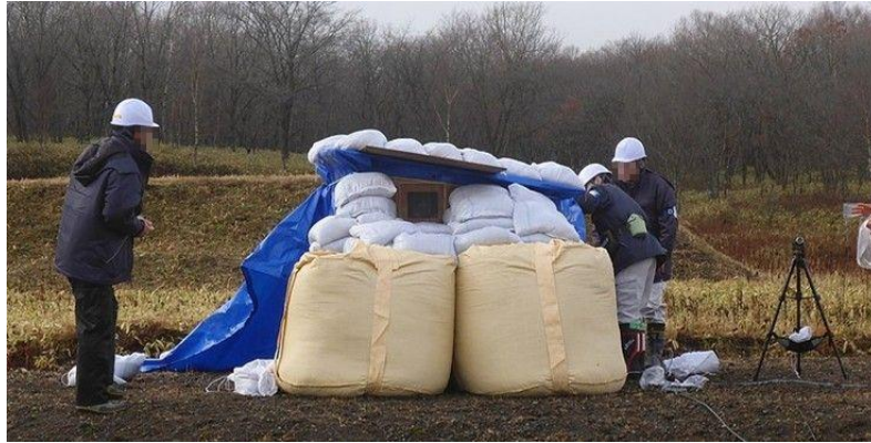
カメラボックス（90 度方向）外観
