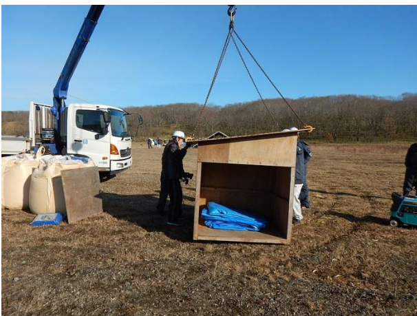
計測ボックス設置作業
