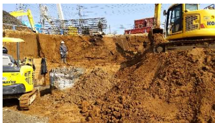
現場作業の様子
