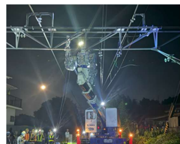
ロボットによるビームの塗装作業 (写真提供：JR西日本)
