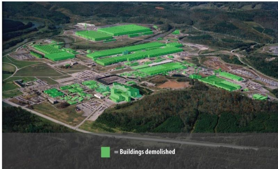
図 6-13 ETTP で解体された建物 188
