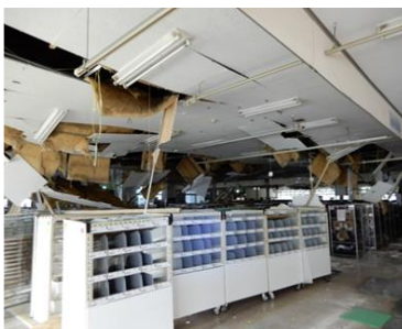
隆起した浄化槽（左）、天井の落下（中）、土間復旧工事（最大 230 mm 沈下）（右）
