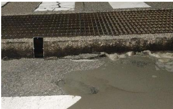
雨水側溝の隆起（左）、構内道路の段差（右）など、地盤に起因する被害が生じた
