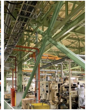
鉄骨の補強後
