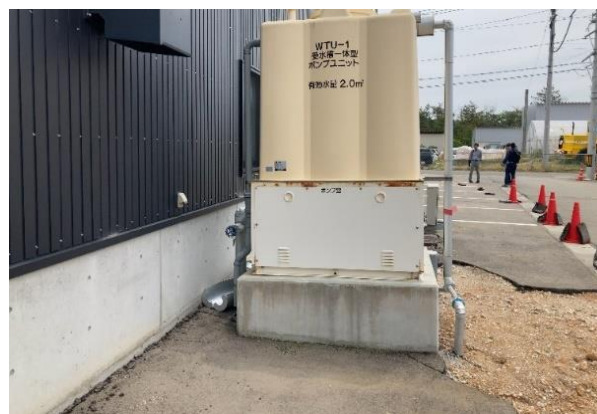
受水槽の基盤が沈下し基礎も損傷
