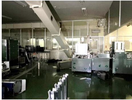
排気ダクトの落下（左）、設備や配電盤の転倒（右）
