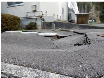
隆起した浄化槽（左）、天井の落下（中）、土間復旧工事（最大 230 mm 沈下）（右）
