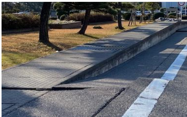
雨水側溝の隆起（左）、構内道路の段差（右）など、地盤に起因する被害が生じた
