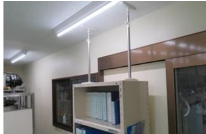
震災後に転倒防止策を追加（左）、設備には耐震マットを設置（右）
