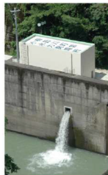
1頁右及び2頁 有田川町二川小水力発電所 1頁左 有田川エコプロジェクトロゴ /出所：有田川町
