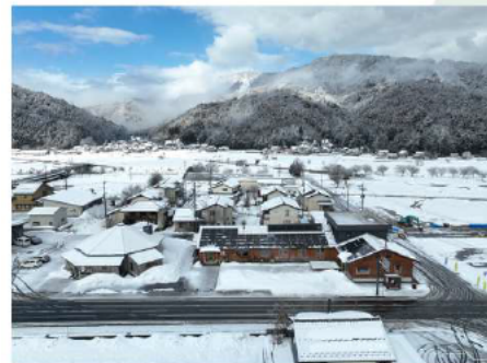
あそびハウスこともと森（1頁及び2頁写真） ／出所：池田町役場（令和7年1月撮影）
