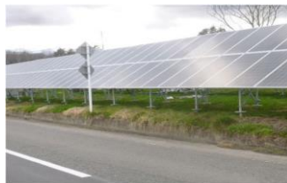
柵塀の未設置、又は第三者が容易に発電設備に近づくことができる
