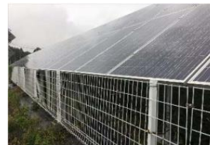
柵塀の未設置、又は第三者が容易に発電設備に近づくことができる
