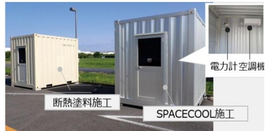
放射冷却フィルムのコンテナハウスへの導入事例
