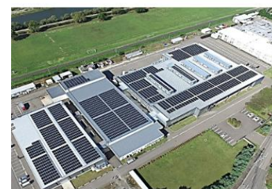
会津工場の太陽光パネル
