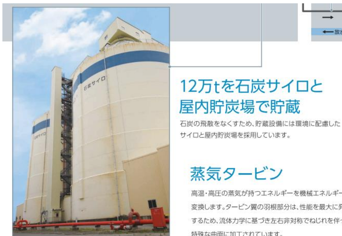
図表 128 広野火力発電所石炭サイロ
