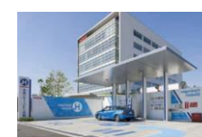
水素ステーション
