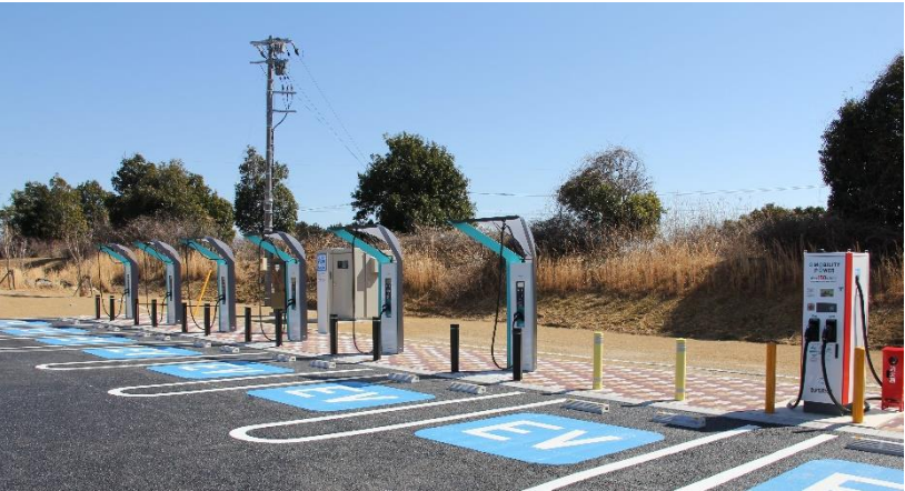
(出典) (株)e-Mobility Power ・浜松サービスエリア（下り）の150kW級急速充電器（写真右） ・6口マルチタイプ急速充電器（写真左）
