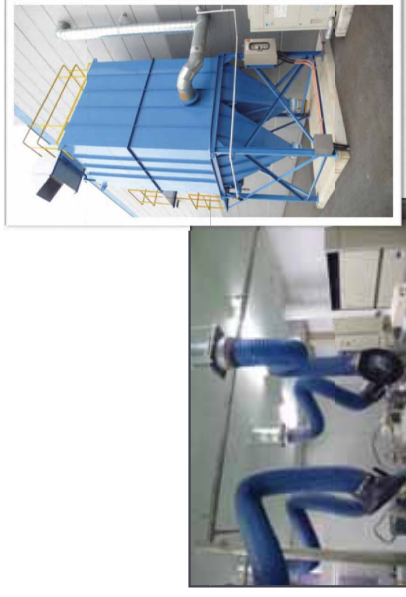
粉末を局所排気により除去 (バグフィルター)
