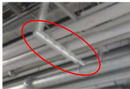
【配管の吊り金具の補強】
