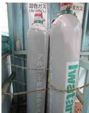
【ガスボンベの転倒防止】
