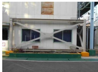
【建屋外の筋交い（ブレース）による補強】
