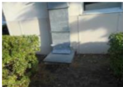
【鉄板による補強】
