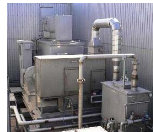
図-1 触媒燃焼装置
