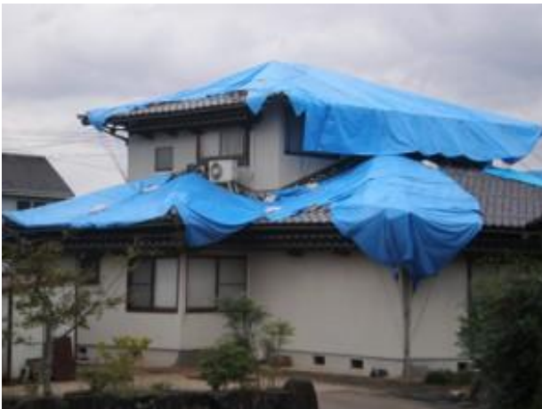
屋根用応急シートの施工例
